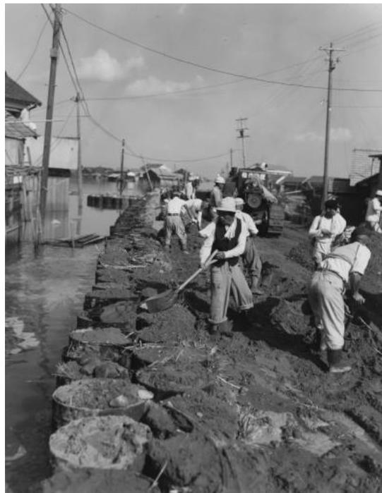
国道1号線復旧工事のドラム缶工法
