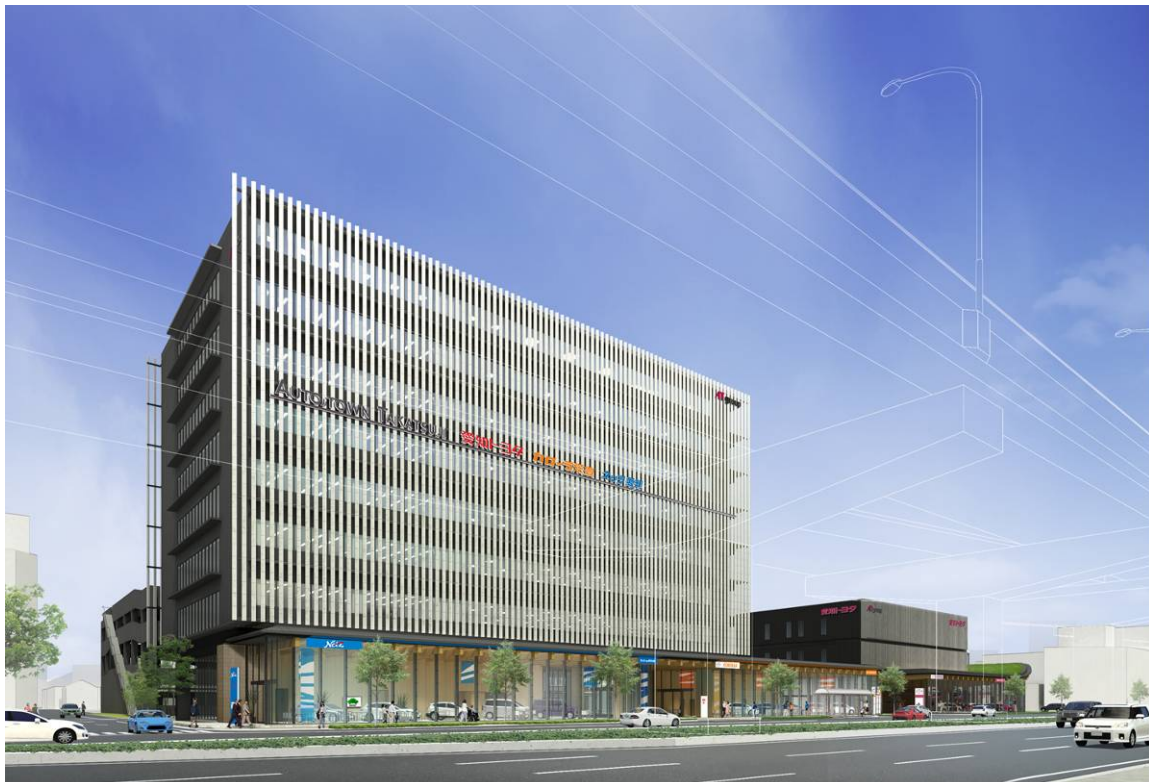
ATグループ本社 南館 (南東側)
